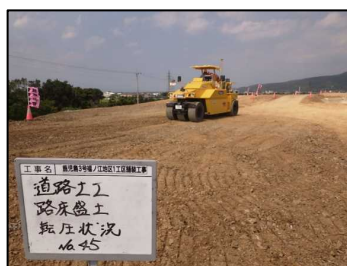
GNSS締固め管理
