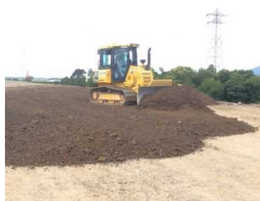
MCブルドーザによる敷均し
