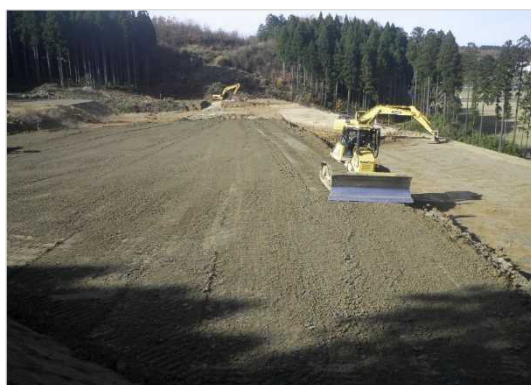
マシンコントロールブルドーザ による盛土敷均し
