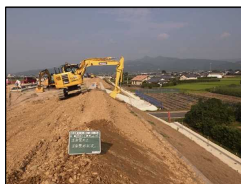
MCバックホウを使用した 法面整形
