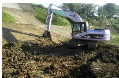
MGバックホウによる 切土法面整形
