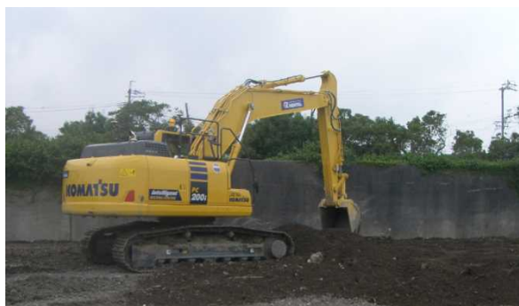
ICT建機(MCバックホウ) による施工
