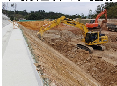
MCバックホウによる法面整形
