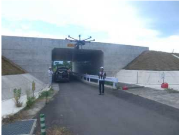
UAVによる起工測量
