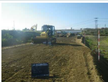
MCブルドーザによる敷均し
