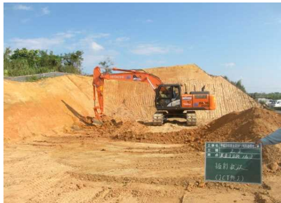
MCバックホウ掘削・法面整形状況
